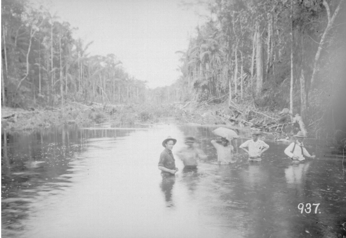
Obreros de la construcción atravesando riberas y arroyos anegados por las aguas de las lluvias.
