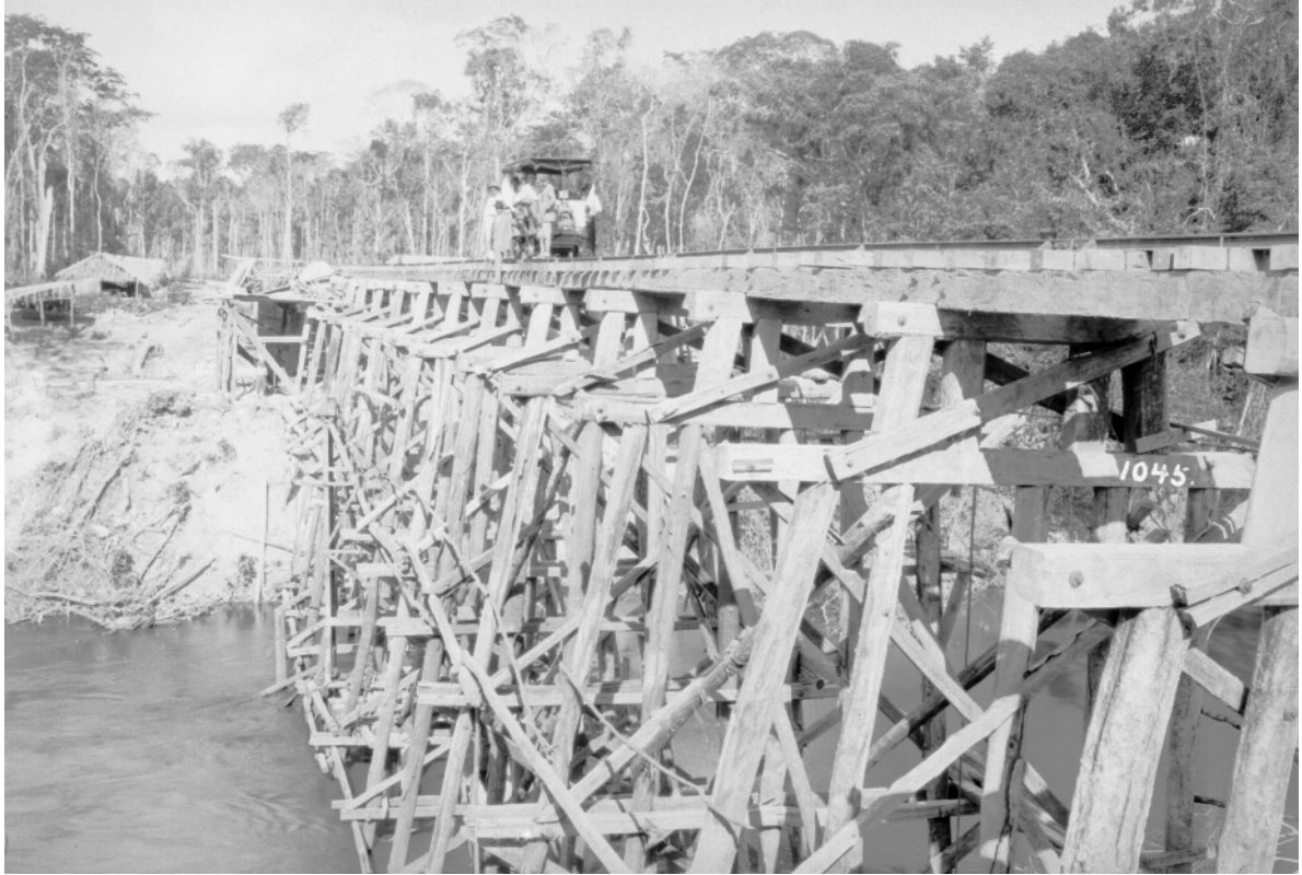
Grupo de operarios junto a un vagón de línea.
