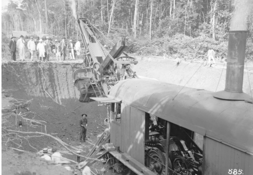
Excavadora a vapor en las obras de fundición de la construcción de la ferrovía Madeira-Mamoré.
