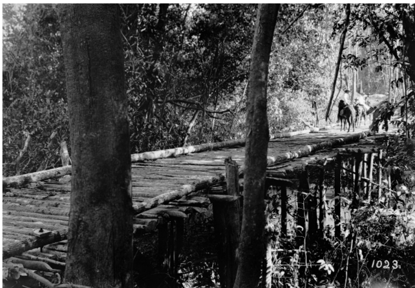
Puente de madera sobre Igarapé.
