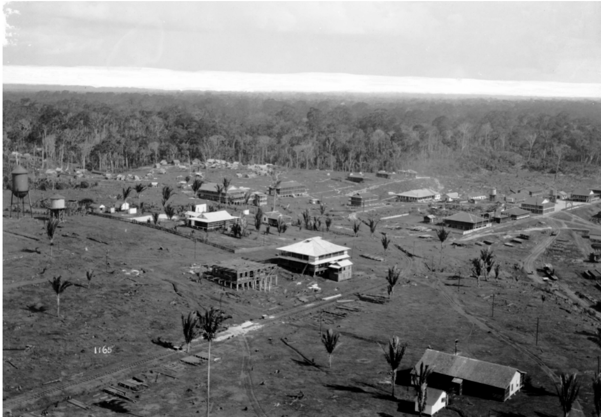
Porto Velho en la época del viaje de D´Ozouville a la ciudad
