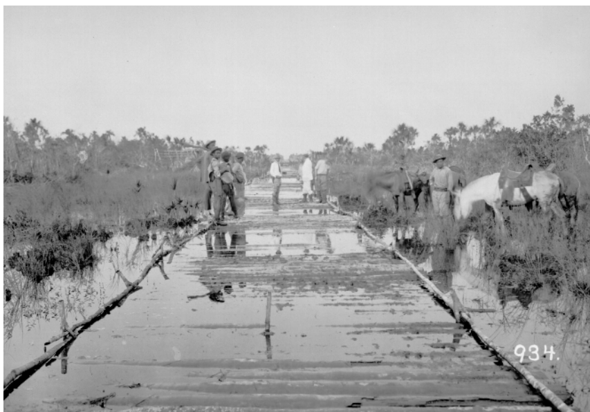
Estiba de troncos de palmera en tramo pantanoso en la recta del río Abunã.
