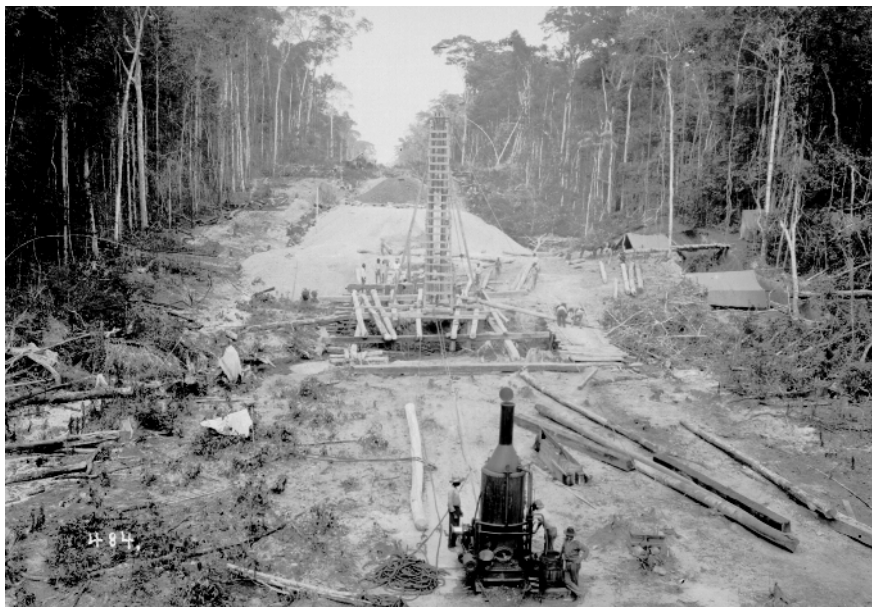
Trabajadores en obras de fundición en la vía férrea.
