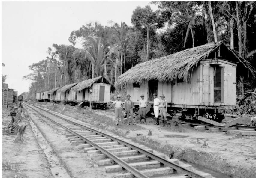
Campamento hecho con vagones cubiertos de hojas de palmera para suavizar el calor debido al fuerte sol.
