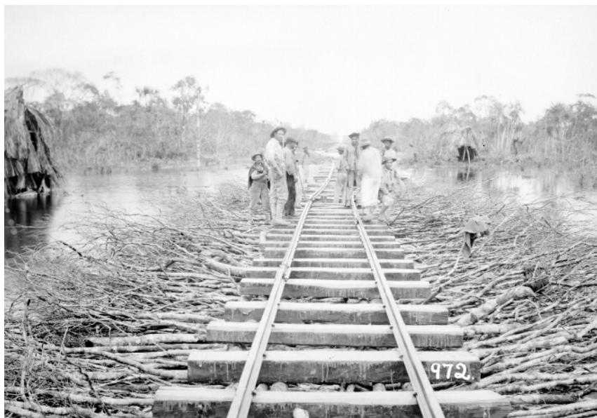
En un tramo pantanoso del río Abunã, un grupo de obreros asienta los raíles sobre una estiba de ramas y piedras.
