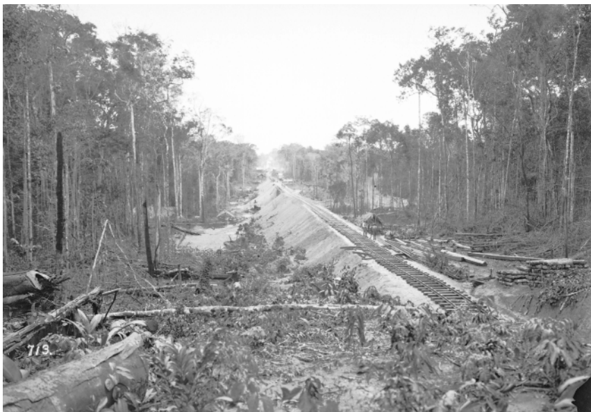
Terraplén en un tramo comprendido entre los ríos Mutumparaná y Abunã.
