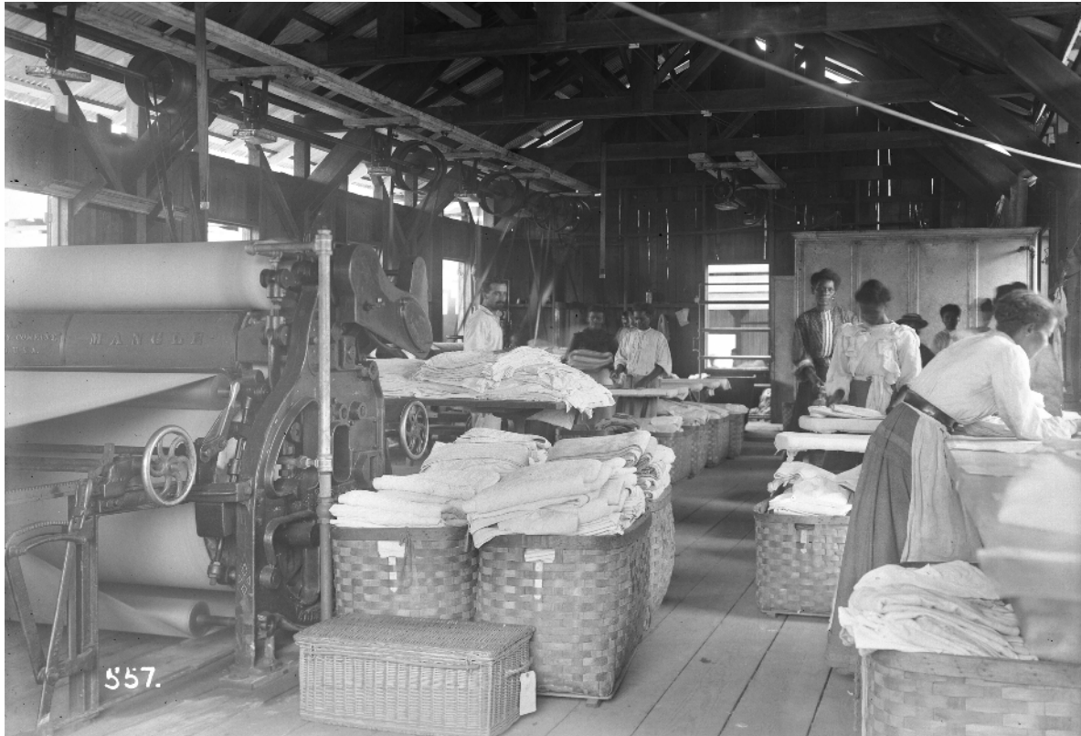
Aspecto interno de la lavandería a vapor en Porto Velho.
