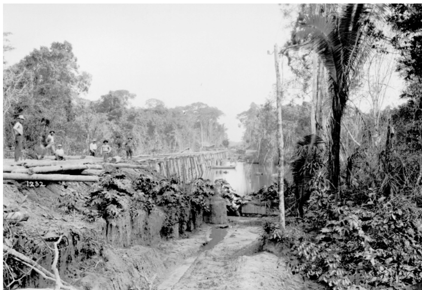
Obreros en las obras de construcción de la ferrovía en un afluente del Río Madeira.
